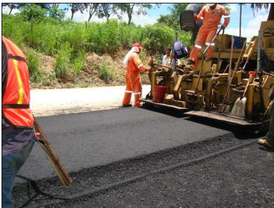
Colocación en obra de aglomerado asfáltico.
